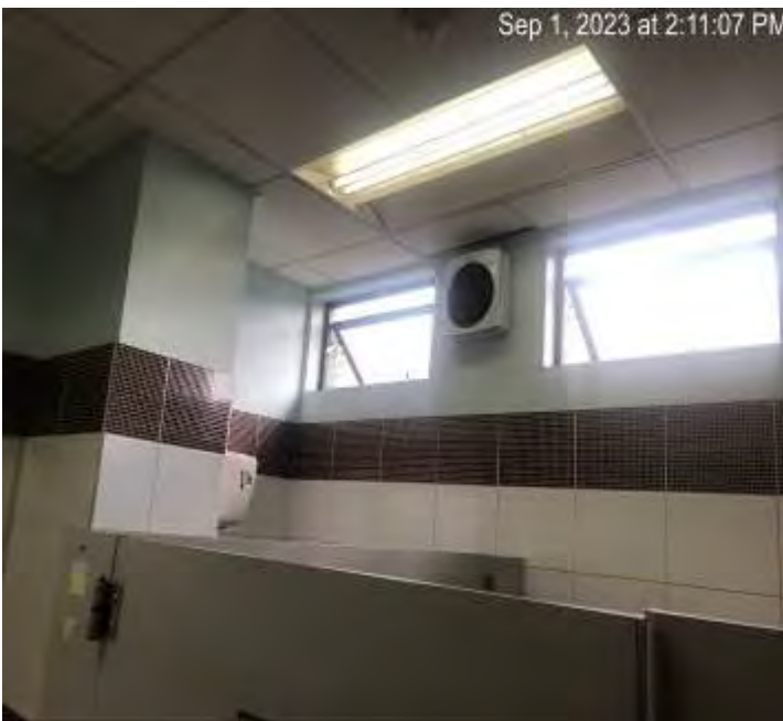
Xpelair Toilet Wall Exhaust Fan
