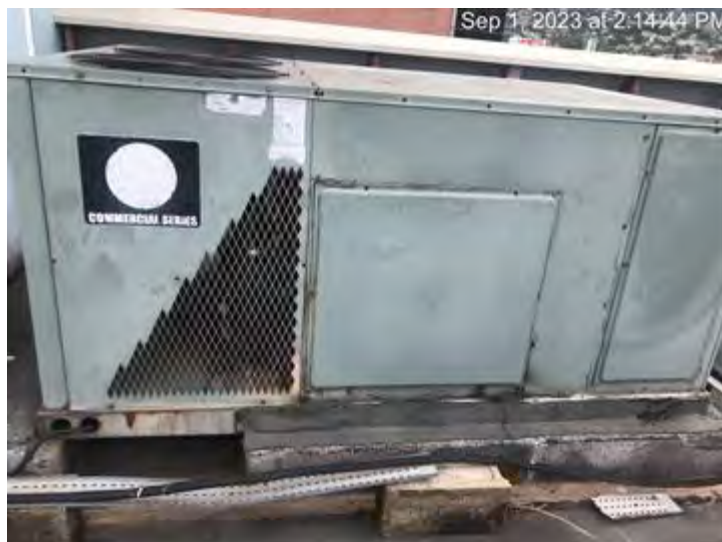
Rheem 12.5 Ton Package AC unit
